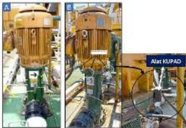
Gambar 24. A) Sebelum dan B) Sesudah Pemasangan KUPAD
