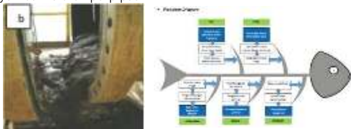
Gambar 71. Flok Minyak Pada Perpipaan dan Fishbone Diagram Sebelum Adanya Program
